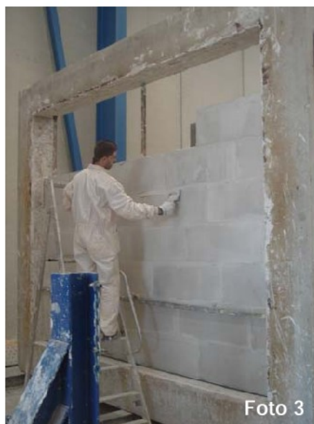
Fotos 2 y 3: Construcción de fábrica de bloque "Lateroyeso 6 LS" sobre banda EEPS inferior
