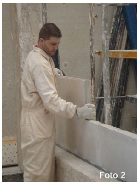
Fotos 2 y 3: Construcción de fábrica de bloque "Lateroyeso 6 LS" sobre banda EEPS inferior
