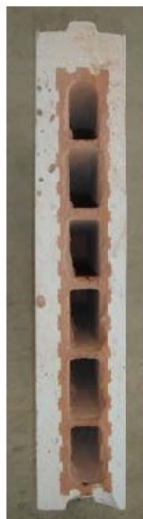
Foto 1: Sección transversal de bloque "Lateroyeso 6 LS"
