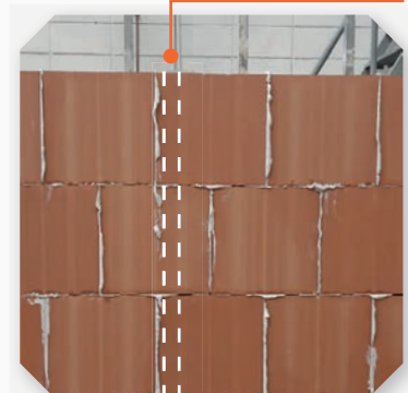
Estriado de las piezas coincidente en las hiladas
