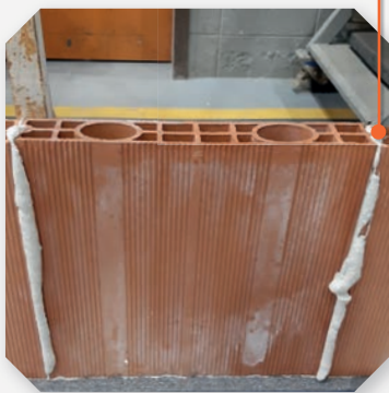
Montaje con pegamento escayola
