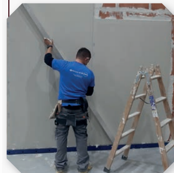
2 Colocación de la placa de yeso laminado ajustando su planeidad con la regla de pañear
