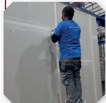
3 Tratamiento de las juntas entre placas: encintado y aplicación de pasta de juntas
