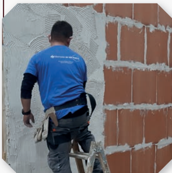
1 Aplicación de una capa continua de pasta de agarre sobre la fábrica para adherir la placa
