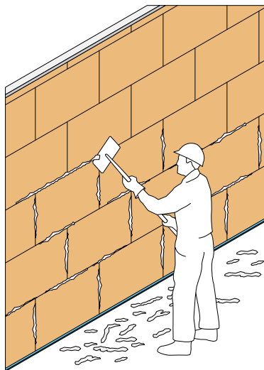
Figura 71. Cepillado de la fábrica.
